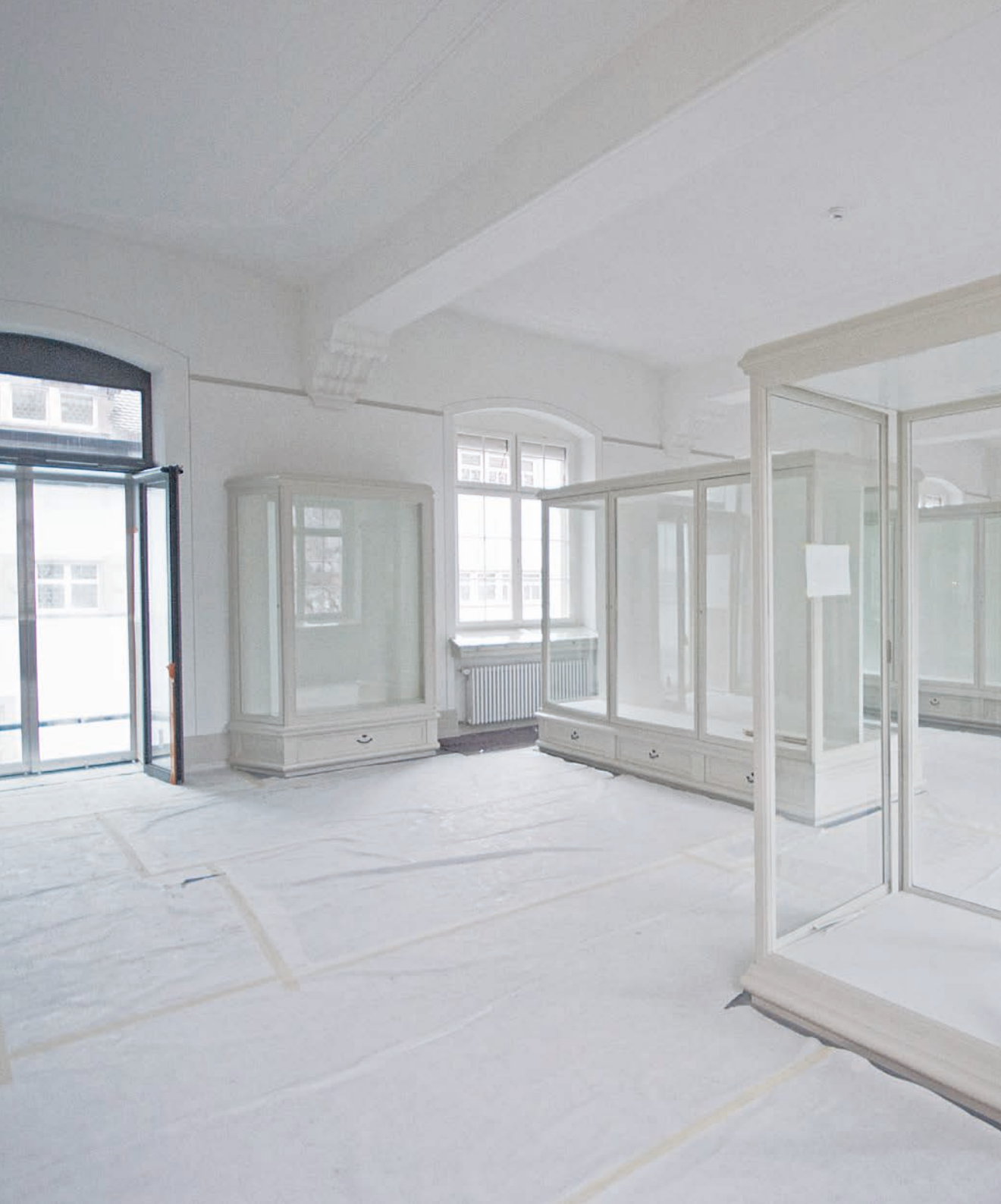
Renovierter Ausstellungssaal im Obergeschoss
