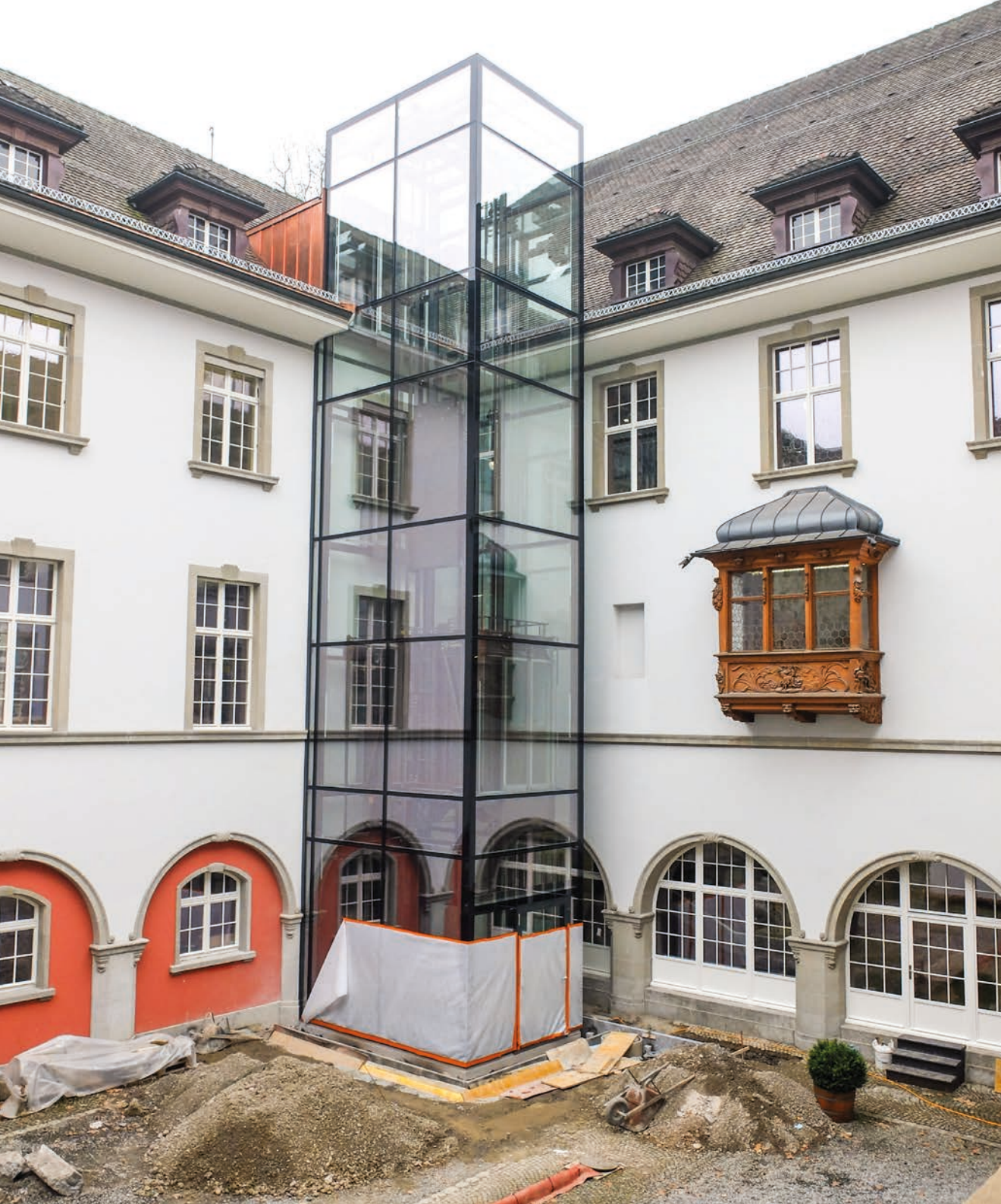
Neuer Liftturm im Innenhof
