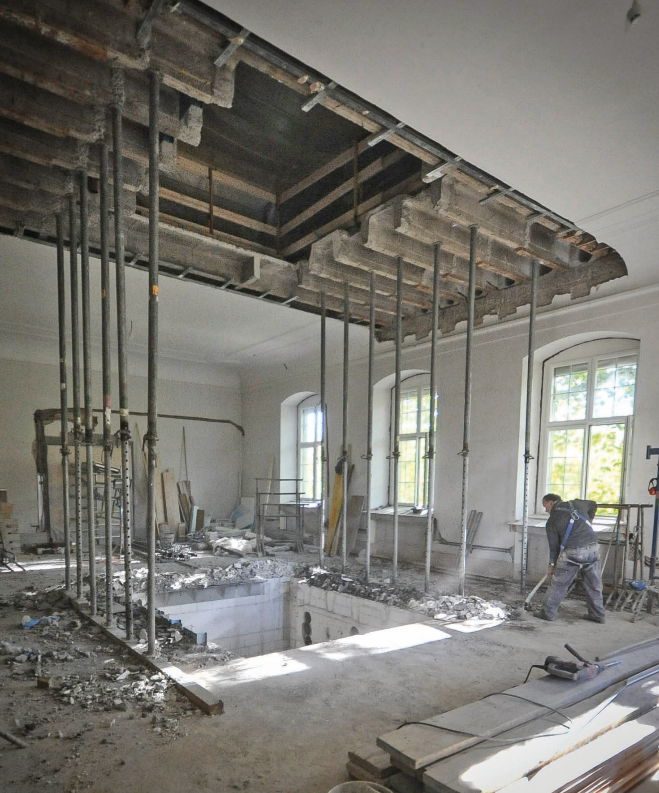
Abbruch Liftschacht im Obergeschoss
